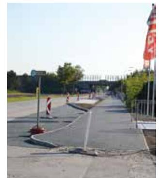
Infolge der Errichtungsarbeiten wird auch die gesamte Landesstraße (Fahrbahn) durch den NÖ Straßendienst mit einer neuen Asphaltdeckschicht versehen.
