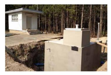
Beim Wasserwerk II am Triftweg wird eine Drucksteigerungsanlage gebaut, um das Gemeindegebiet Wöllersdorf über die leistungsstärkeren Brunnen III und IV (in Steinabrückl) versorgen zu können. Diese Brunnen sind auch an die Aktivkohleanlage angeschlossen. Die Inbetriebnahme wird in ca. drei bis vier Wochen erfolgen.
